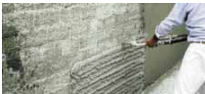
Мал. 1. Нанесення штукатурки.
