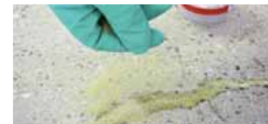
Мал. 14. Посипка піском для адгезії подальших шарів.
