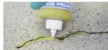
Мал. 13. Заливка тріщин з MC-Estrifan RIS-SL.
