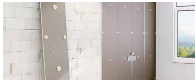
Мал. 21. Вирівнювання стін за допомогою будівельних плит MC.
