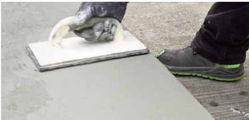
Мал. 36. Ремонт сходів за допомогою Emcefix Floor.
