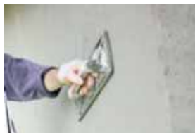
Мал. 2. Затирання штукатурки.
