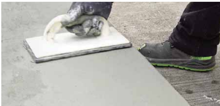
Мал. 36. Ремонт сходів за допомогою Emcefix Floor.
